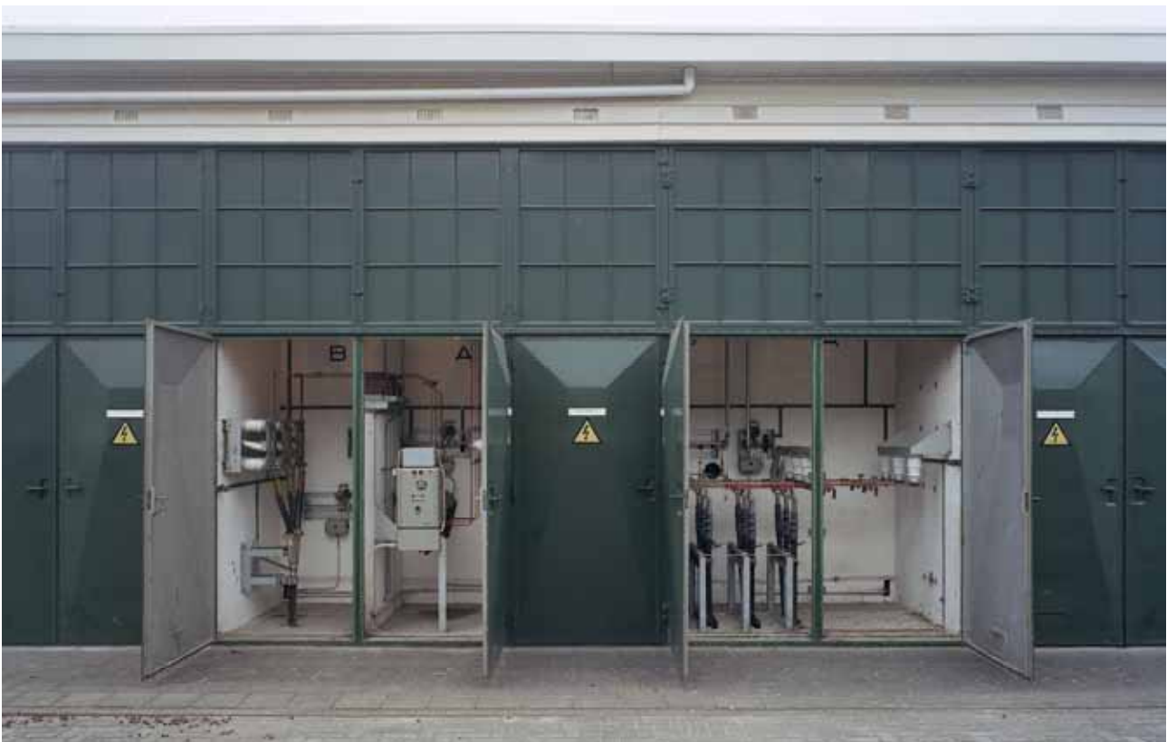
Het schakelstation aan de President Rooseveltlaan ontworpen door architect Alphons Boosten, een rijksmonument dat spijtig genoeg gesloopt moet worden. Fotograaf Kim Zwarts heeft het bouwwerk voor de toekomst treffend vastgelegd, een voorbeeldig 'portret' van een uitgewogen bedrijfsgebouw.
